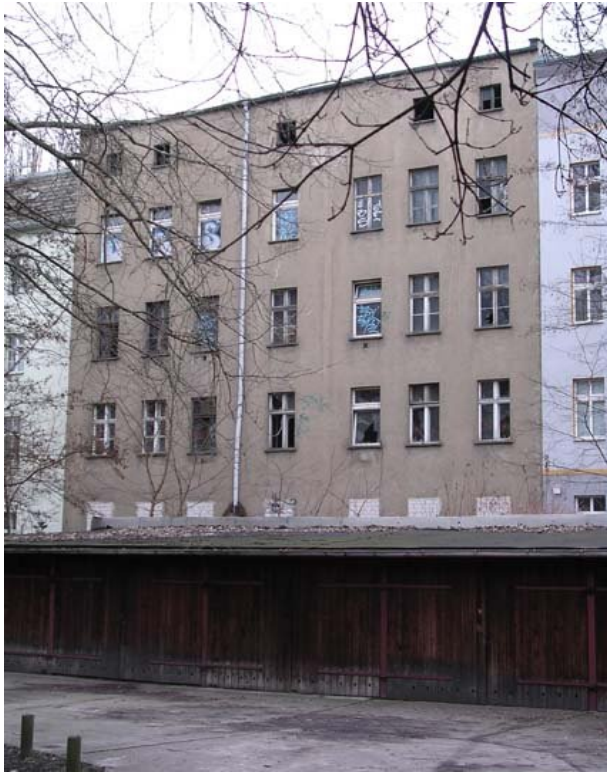
Ostansicht vor Sanierung mit vorgelagertem Garagenhof
