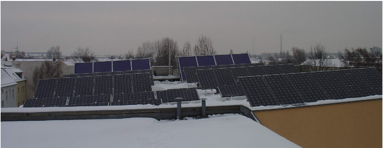
Neu errichtetes Dach mit EPDM-Deckung, maximal ausgenutzt: Solaranlage und 8,8 kW peak -PV-Anlage installiert, Dach-Windkraftanlage vorgesehen
