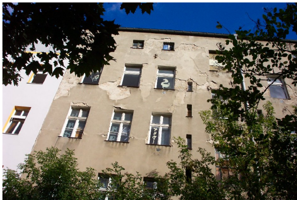
Westansicht vor Sanierung
