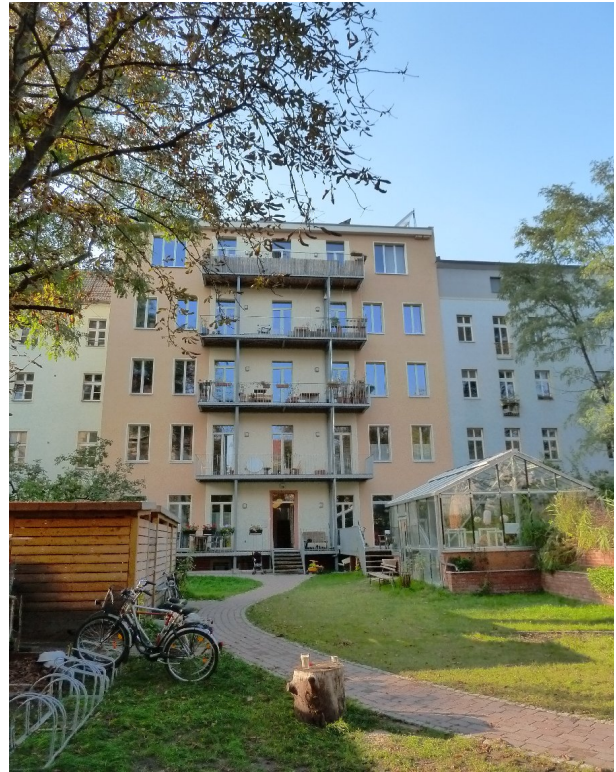
Ostansicht nach Sanierung mit Gewächshaus, Wasserfilteranlagen, Solar- und PV-Anlagen auf dem Dach
