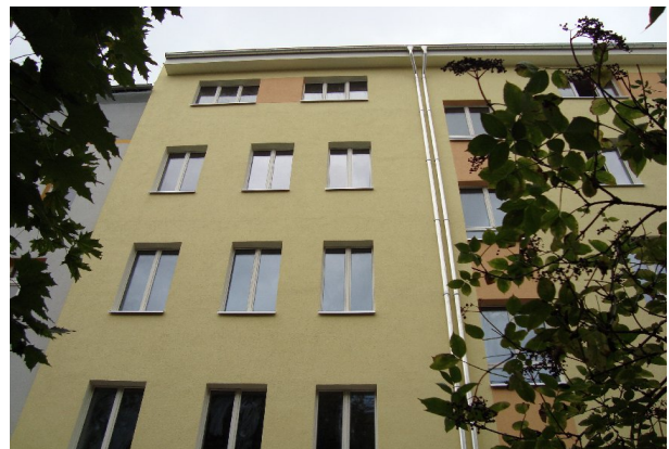
Westansicht nach Sanierung mit hoch gedämmter Fassade, Fenstern mit 3-fach Verglasung, Regenwasser- sammlung vom Dach zur Aufbereitung
