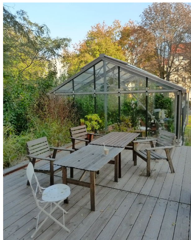
Terrasse mit Vertikalpflanzenfilter für Regenwasser links und Gewächshaus mit Fließbettfiltern
